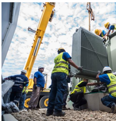
Assemblage des radiateurs sur le transformateur par les équipes
