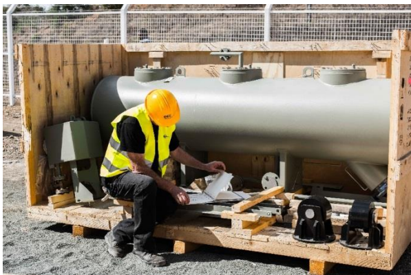
EEC a fait appel à un expert de métropole pour le montage du transformateur HTA.
