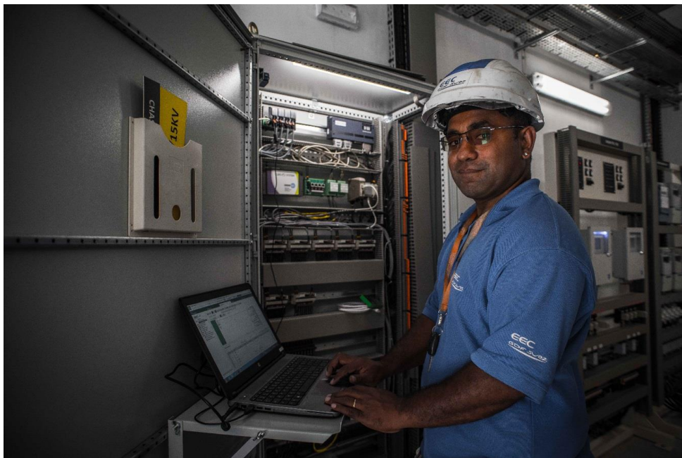
Configuration de l'armoire automate, le terminal permettant de répertorier et gérer numériquement toutes les données du site.
