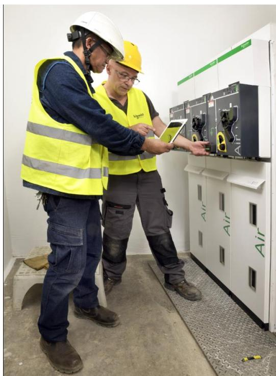
*La nouvelle génération de cellules moyenne tension isolée dans l'air à coupure dans le vide. De gauche à droite, le technicien du service Protection Automatismes Mesures de EEC et le technicien expert Schneider.*
